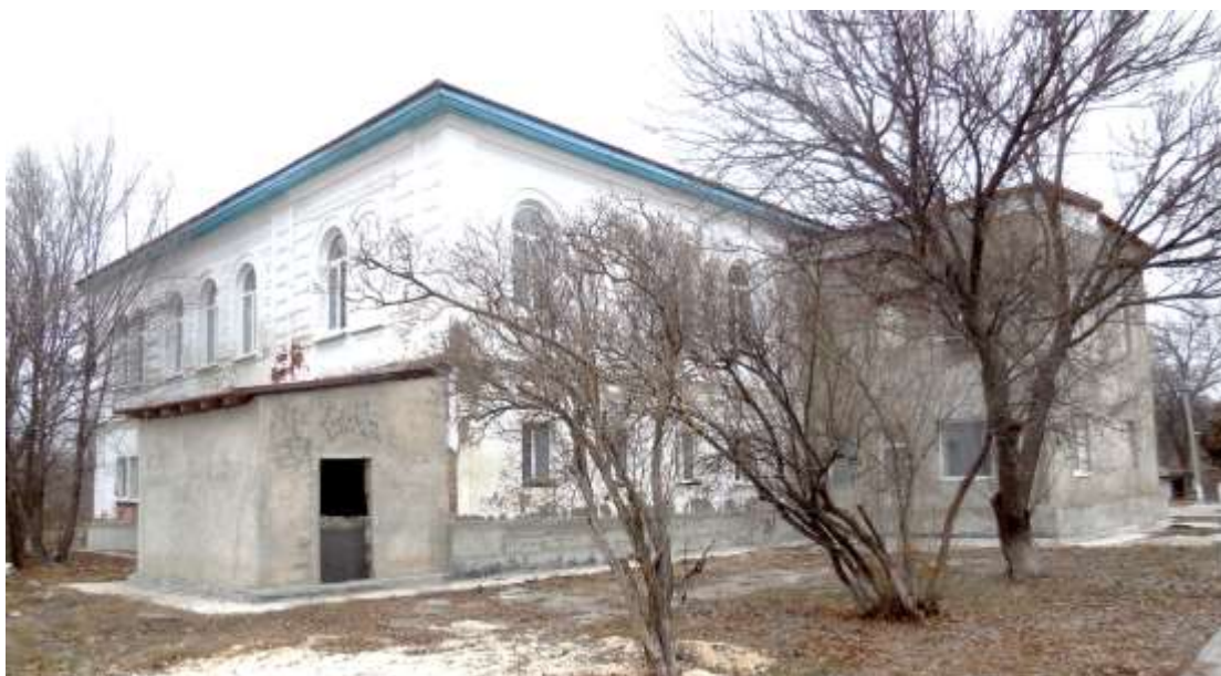
Будинок купця Марченка (корпус водолікарні), кін. XIX – поч. XX ст., Набережна вул., 3
