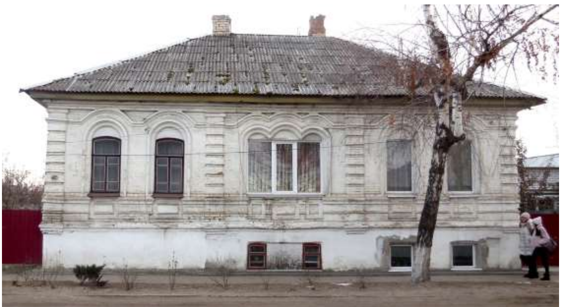
Будинок житловий, кінець XIX – поч. XX ст., Слобожанська вул., 50
