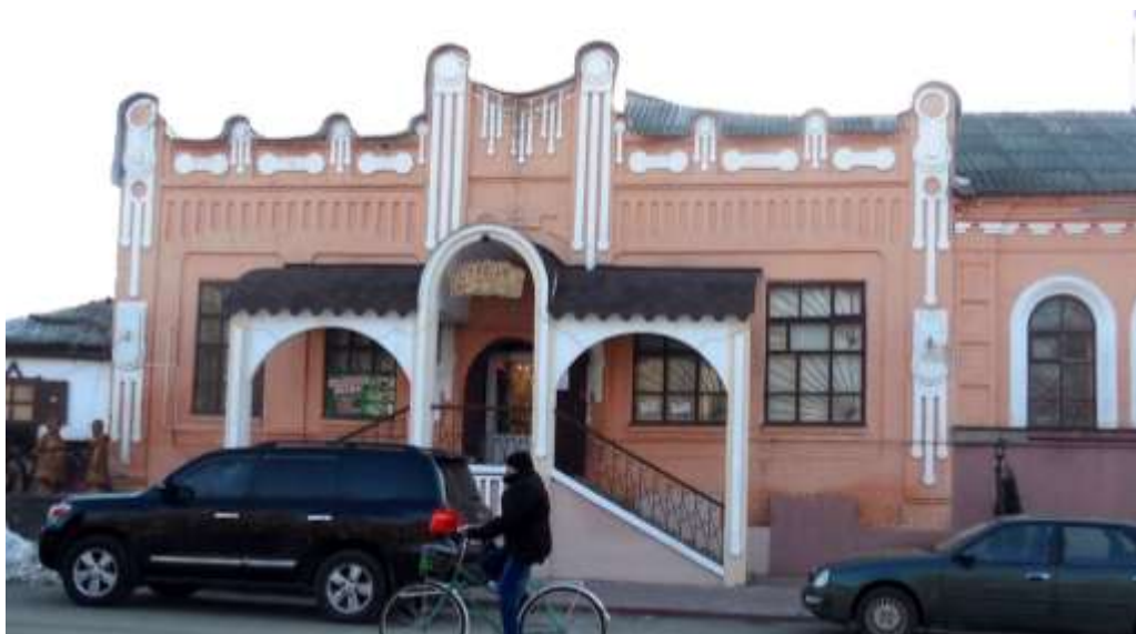
Будинок типографії Башлая, поч. XX ст., Центральна вул., 30
