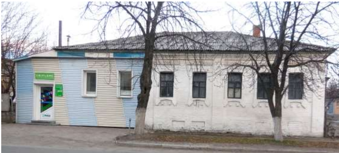
Будинок кін. XIX – поч. XX ст. Вул. Монастирська, 25.
