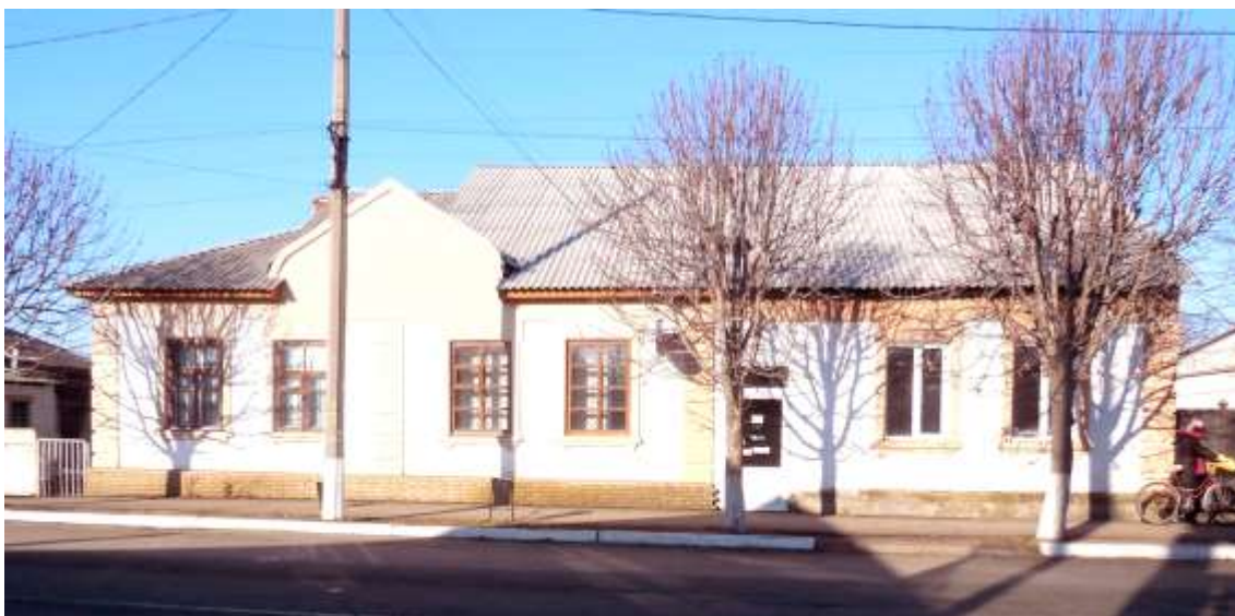
Будинок поч. XX ст. Вул. Центральна, 43.
