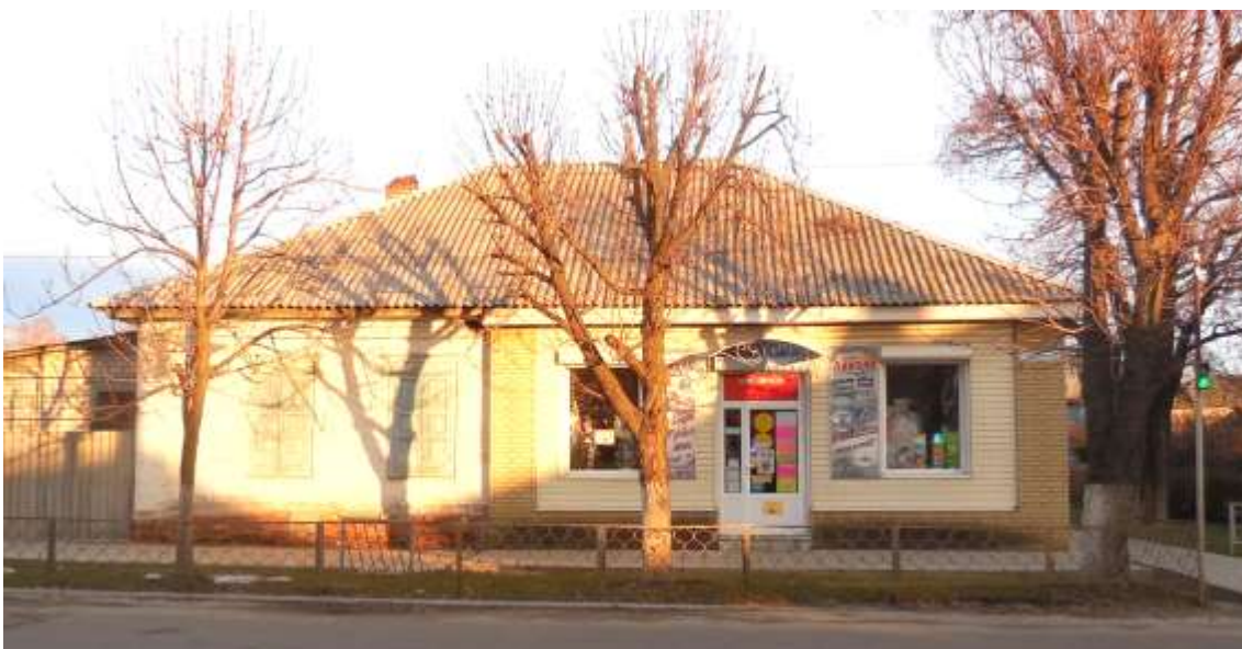
Будинок кін. XIX – поч. XX ст. Вул. Монастирська, 31.
