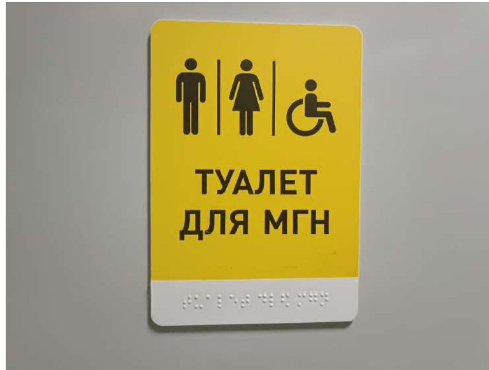
Фото № 9. Тактильна табличка - показчик з шрифтом Брайля універсального санітарного вузла, в тому числі для осіб з інвалідністю та інших маломобільних груп населення
