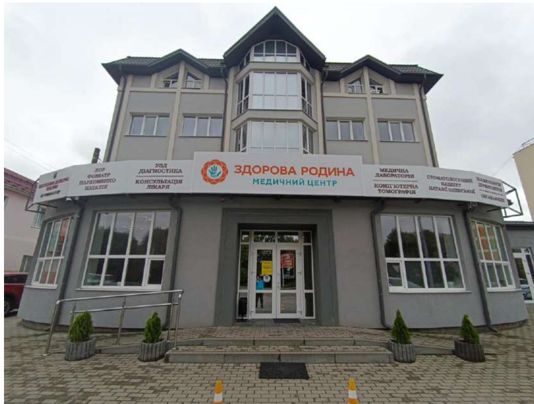
Фото № 1. Головний фасад. Головний вхід в будівлю обладнаний пандусом з ухилом 8%
